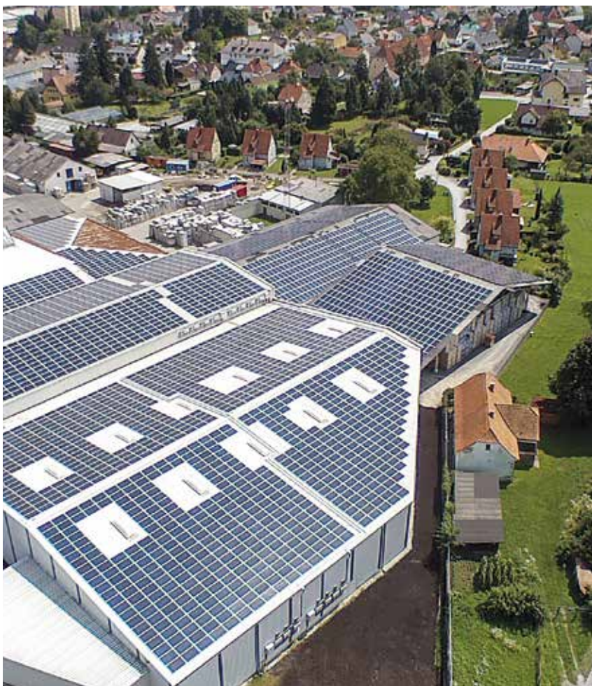
Photovoltaik-Anlagen auf den Stoelzle-Betriebsgebäuden
